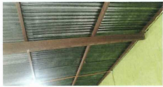
Foto 2: Cambio de vigas oxidadas por vigas galvanizadas de 4x4 chapa 16 mm.
