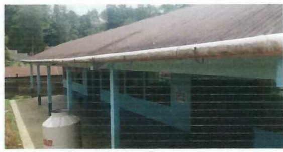
Foto 5: Cambio de canal, pescantes y bajadas de agua.
