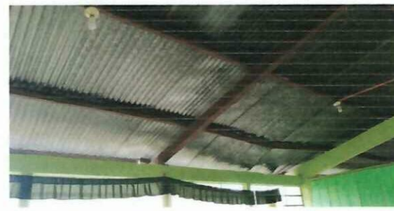
Foto 3: Cambio de costaneras oxidadas y dobladas por costaneras galvanizadas de 2x4 de 1.5 mm.
