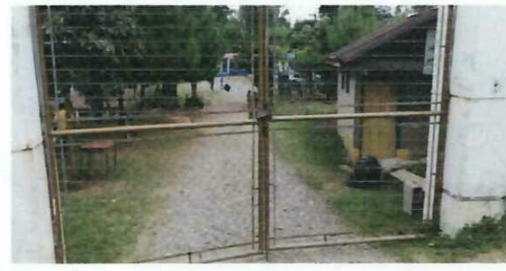
Foto 6: Reparación del Portón de acceso principal a la escuela por una con tubo cuadrado y lámina.
