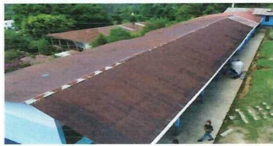
Foto1: Cambio de láminas acanaladas oxidadas por láminas troqueladas color rojo, calibre 26 mm.
